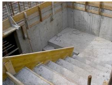
TREPPENLAUF IN STAHLBETON MIT SCHALUNG
