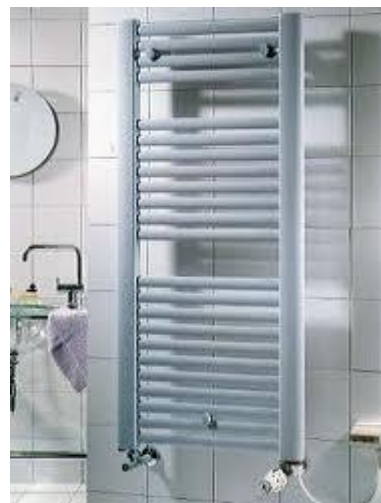
BADHEIZKÖRPER AM HEIZUNGSKREISLAUF
