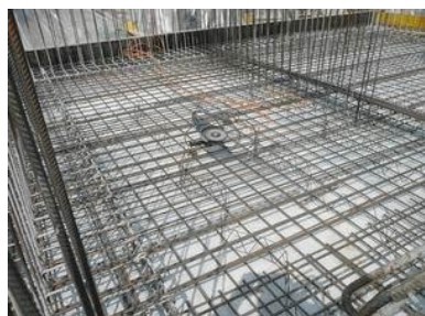
ARMIERUNG DER FUNDAMENTPLATTE
