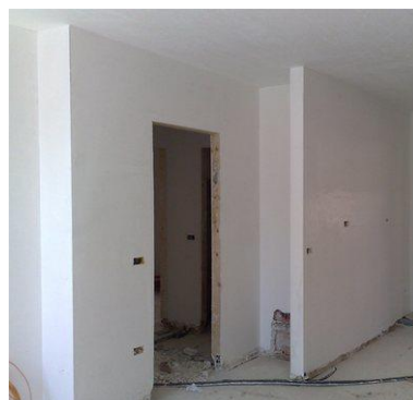
TRENNWÄNDE IN TROCKENBAUWEISE
