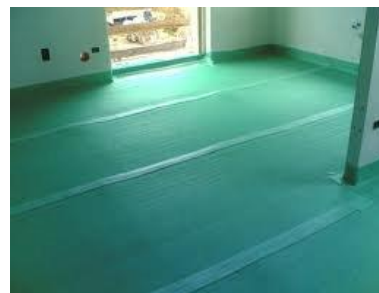
TRENNLAGE AUF DER ROHDECKE VOR DEM ESTRICH
