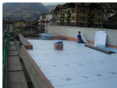
ABDICHTUNG DER DACHDECKE
