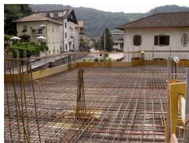
FUNDAMENTPLATTE VOR DEM BETONIEREN
