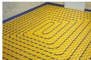
VERLEGTE FUßBODENHEIZUNG VOR DEM ESTRICH
