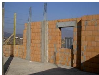
HOCHLOCHZIEGEL MIT HOHER WÄRMEISOLIERUNG
