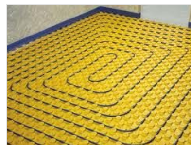
PANNELLI RADIANTI A PAVIMENTO PRIMA DEL MASSETTO
