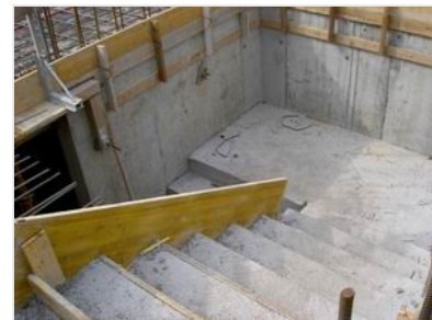
SCALA IN CALCESTRUZZO CON CASSEFORME
