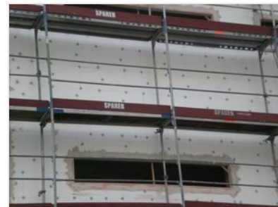
ISOLAMENTO A CAPPOTTO SULLA FACCIATA
