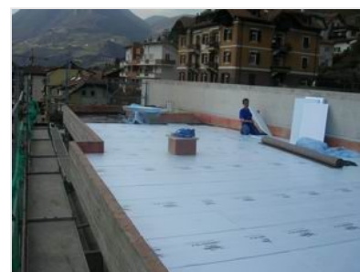
MANTO IMPERMEABILE SINTETICO SUL SOLAIO DI COPERTURA
