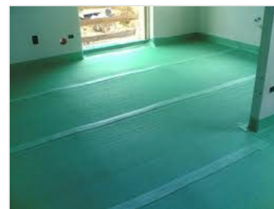
MATERASSINO FONORESILIENTE SOTTO IL MASSETTO GALLEGGIANTE
