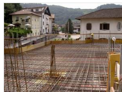
GETTO DELLA PLATEA IN CANTIERE
