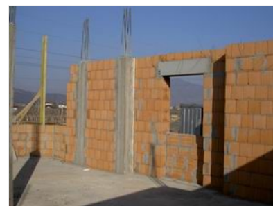
TAMPONAMENTI IN BLOCCHI DI LATERIZIO ALVEOLARE
