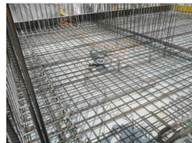
ARMATURA DELLA PLATEA DI FONDAZIONE
