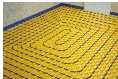
VERLEGTE FUßBODENHEIZUNG VOR DEM ESTRICH
