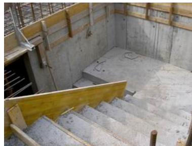
TREPPENLAUF IN STAHLBETON
