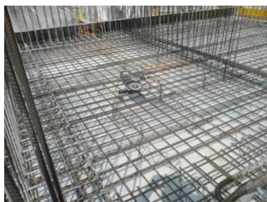
BEWEHRUNG DER FUNDAMENTPLATTE
