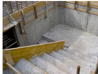
RAMPA DI SCALE IN CALCESTRUZZO ARMATO
