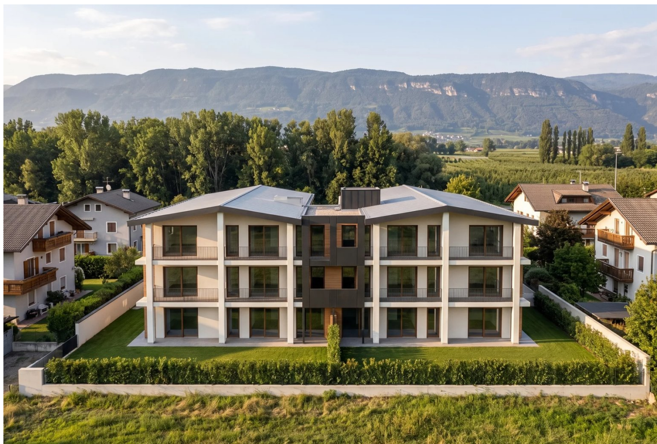
RESIDENCE ROSA, VISTA DAL LATO OVEST
