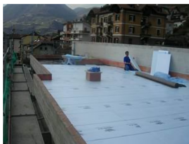
IMPERMEABILIZZAZIONE DELLA COPERTURA
