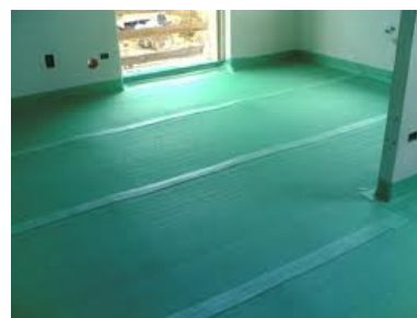
IMPERMEABILIZZAZIONE LIQUIDA INTERNA
