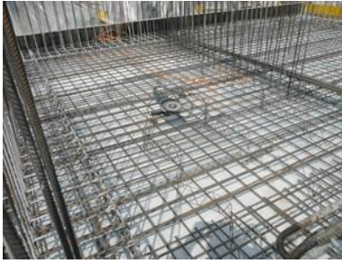
ARMATURA DELLA PLATEA DI FONDAZIONE
