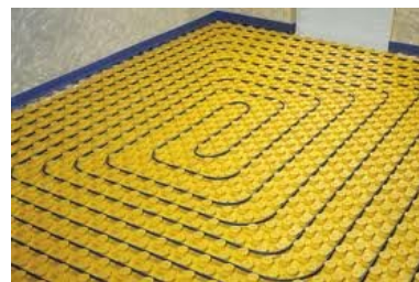
PANNELLI RADIANTI A PAVIMENTO PRIMA DEL MASSETTO
