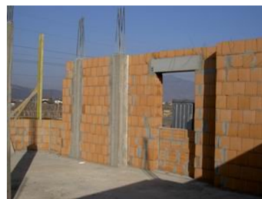
BLOCCHI DI LATERIZIO ALVEOLARE AD ELEVATO ISOLAMENTO TERMICO
