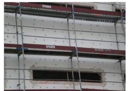
AUSSENLIEGENDE WÄRMEDÄMMUNG DER FASSADE
