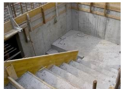
TREPPENLAUF IN STAHLBETON
