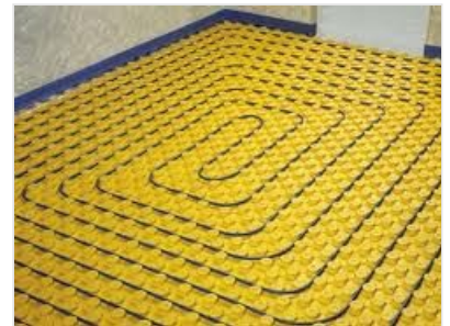
VERLEGTE FUßBODENHEIZUNG VOR DEM ESTRICH
