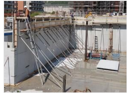
SCHALUNG DER STAHLBETONWÄNDE
