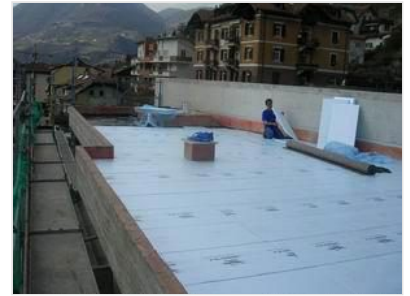
ABDICHTUNG UND DÄMMUNG DER DACHDECKE
