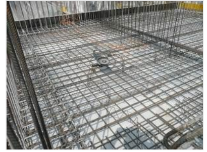
BEWEHRUNG DER FUNDAMENTPLATTE
