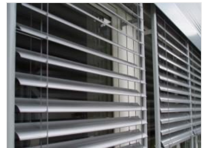
ELEKTRISCH BETRIEBENE RAFFSTOREN
