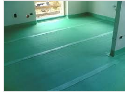
FLÜSSIGABDICHTUNG IM INNENBEREICH
