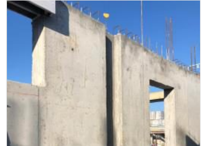
AUFGEHENDES MAUERWERK IN STAHLBETON
