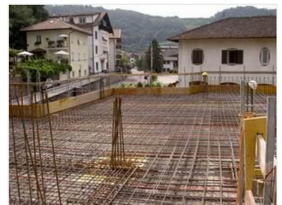
DECKENBEWEHRUNG VOR DEM BETONIEREN
