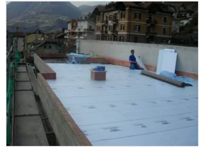
IMPERMEABILIZZAZIONE DEL SOLAIO DI COPERTURA
