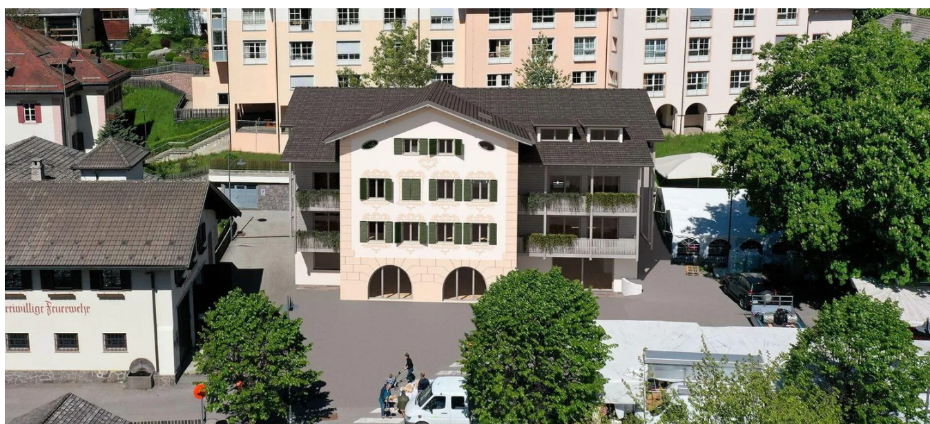
IL GERBERHAUS SULLA PIAZZA GRIES A SARENTINO
