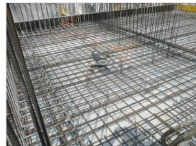
ARMATURA DELLA PLATEA DI FONDAZIONE
