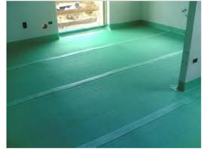
IMPERMEABILIZZAZIONE DEI VANI INTERNI
