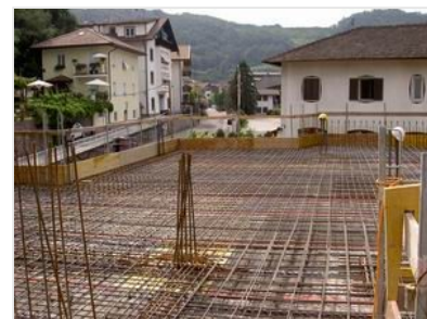
LA PLATEA DI FONDAZIONE IN CANTIERE
