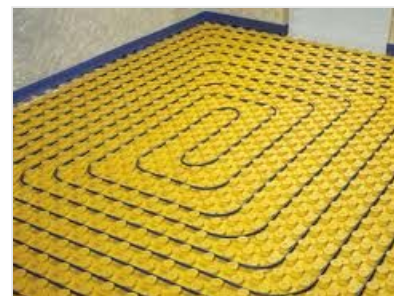
SERPENTINE DEL RISCALDAMENTO A PAVIMENTO
