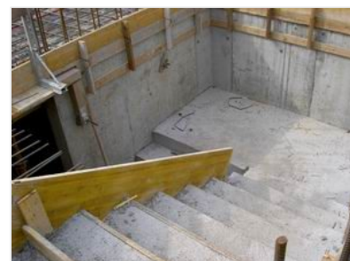
CASSERATURA DELLE STRUTTURE AL PIANO INTERRATO
