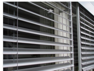
FRANGISOLE IN ALLUMINIO ORIENTABILE
