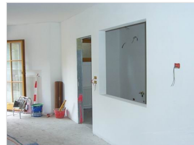
LOCALI INTONACATI PRIMA DELLA PITTURA
