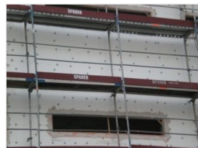
ISOLAMENTO A CAPPOTTO SULLA FACCIATA
